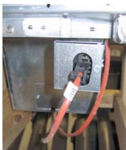
Bild 6 Fäst de vita tvåstiftskontaktarna och koppla in den svarta kontakten i elskåpet såsom visas. * Notera att placeringen av den svarta kontakten kan skilja sig från den på bilden.
