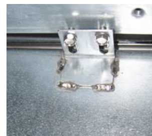
Bild 5: Fäst smältenheten i skenorna på båda sidor.
